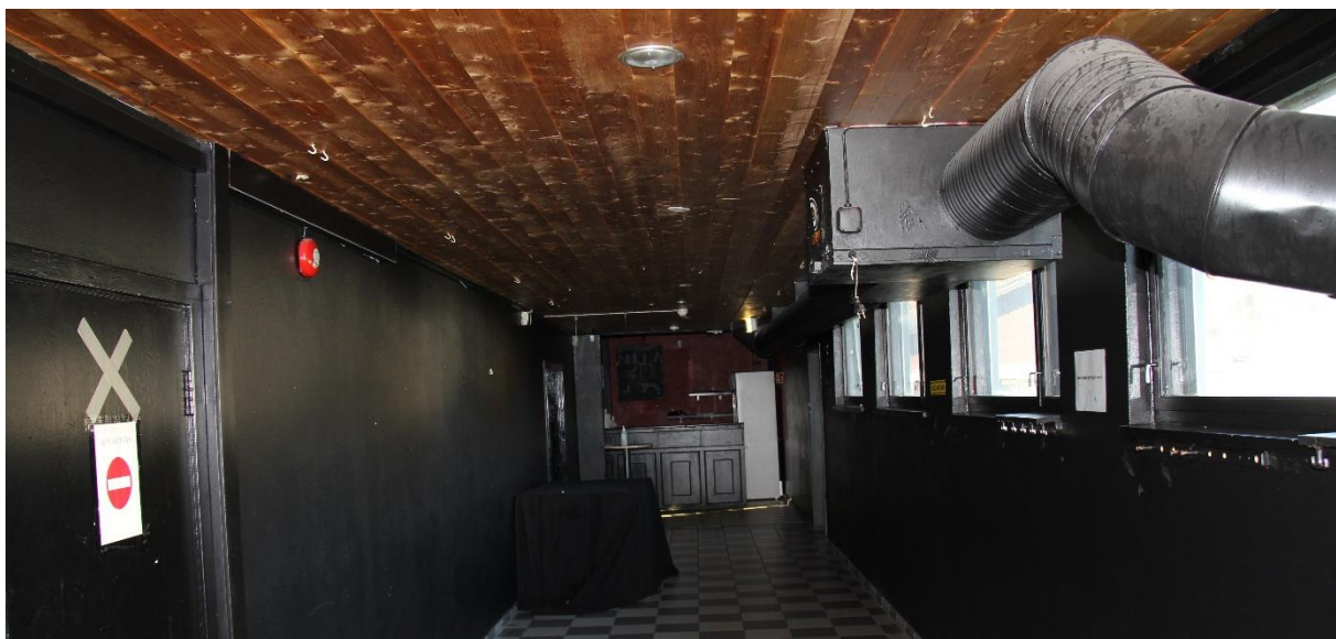
Hovedadkomst og hovedrømningsveg med brennbar himling.
